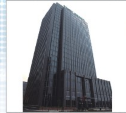
上海长丰大厦 Shanghai Changfeng Building 地点(Place): 上海 Shanghai 面积(Area): 22000m 2 地板类型(Panel Type): OA网络地板
