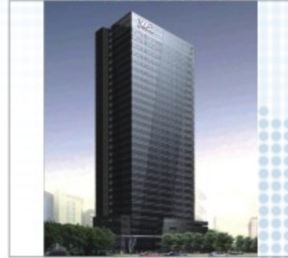
深圳威盛大厦 Shenzhen Weisheng Building 地点(Place): 深圳 Shenzhen 面积(Area): 30000m 2 地板类型(Panel Type): OA网络地板
