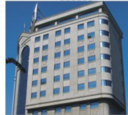
北京电信通信指挥楼 China Telecom (Beijing) Office Building 地点(Place): 北京 Beijing 面积(Area): 15000m 2 地板类型(Panel Type): HPL抗静电地板
