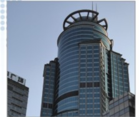
上海巴克莱银行 Barclays Bank Shanghai 地点(Place): 上海 Shanghai 面积(Area): 25000m 2 地板类型(Panel Type): OA网络地板
