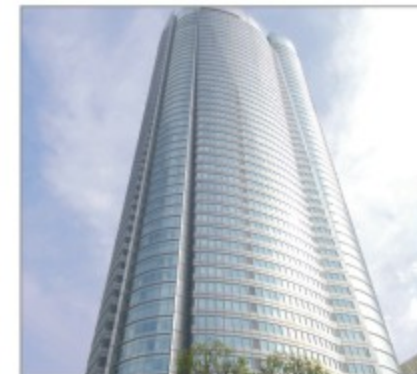
上海杜邦办公大楼 DuPont Shanghai Office Building 地点(Place): 上海 Shanghai 面积(Area): 15000m 2 地板类型(Panel Type): OA网络地板
